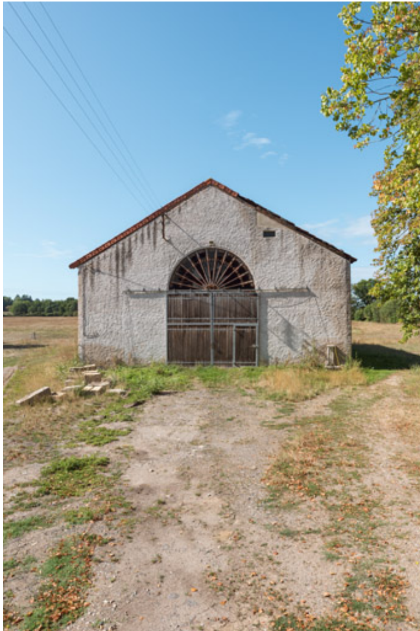
Vue de face (vue rapprochée).
