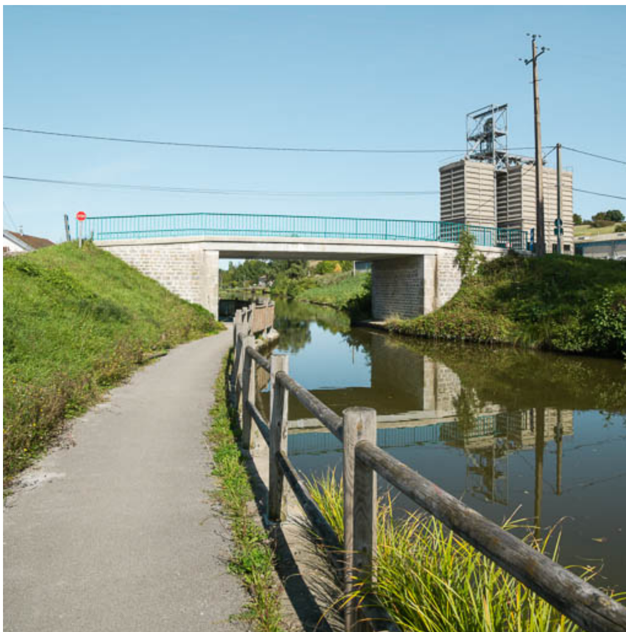
Vue d'ensemble du pont.
