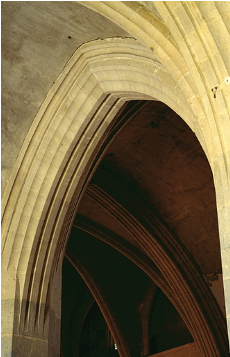
Grande arcade de la septième travée nord.
