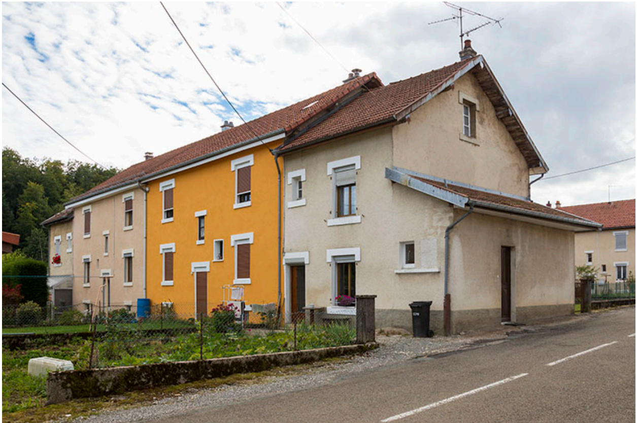
Immeuble au n° 9 : vue d'ensemble, depuis le nord-est.
