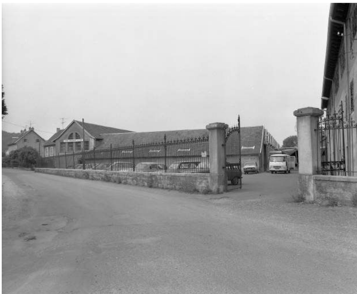
Ateliers en rez-de-chaussée depuis le sud en 1981.
