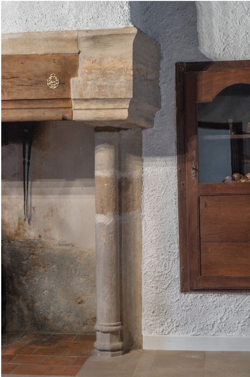
Vue rapprochée du piedroit droit de la cheminée du rez-de-chaussée.
