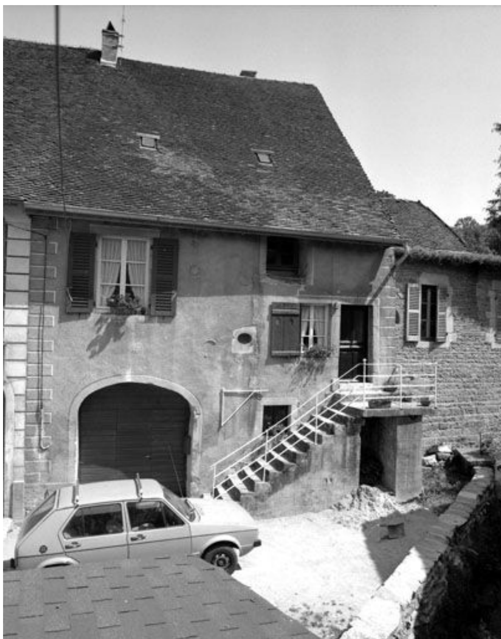
Façade antérieure vue de face.
