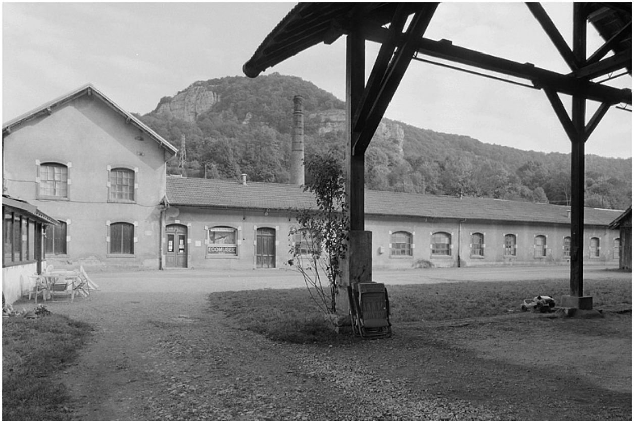
Façade antérieure depuis le sud.
