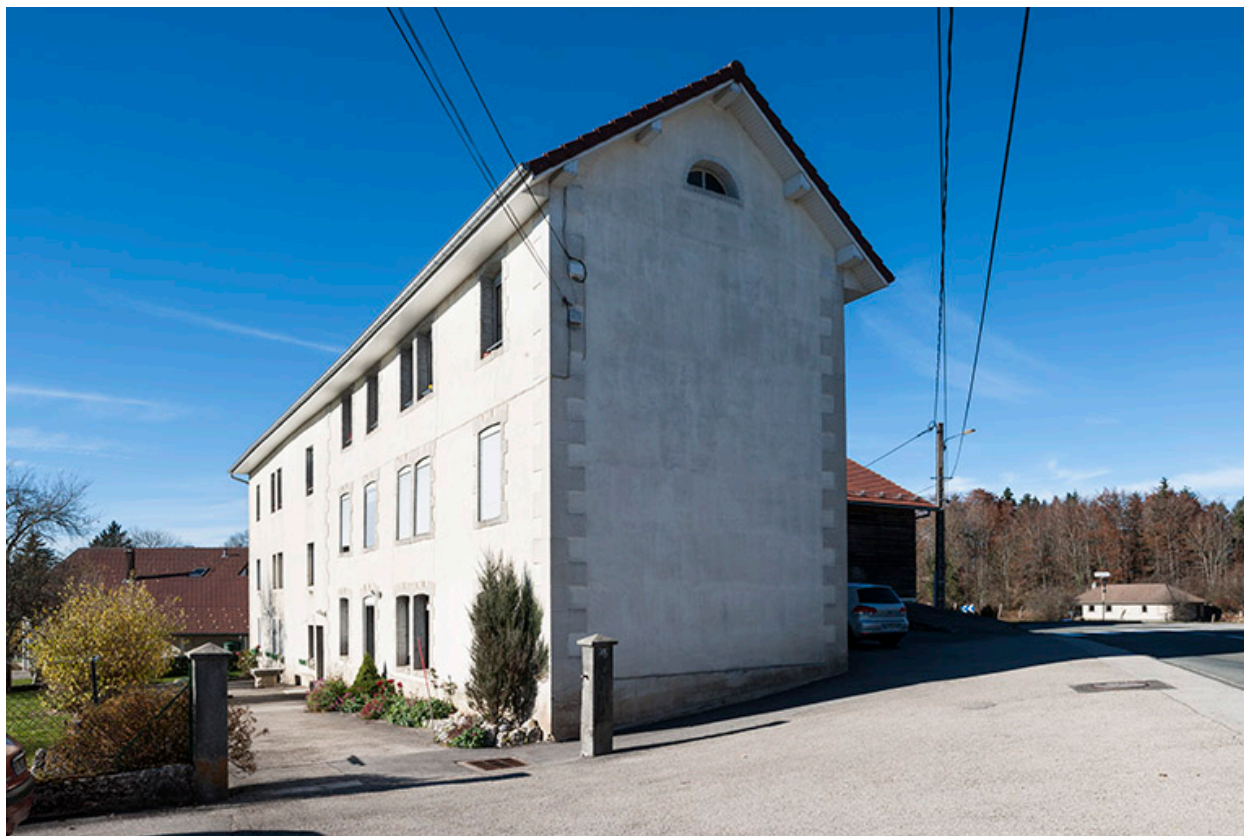
Ferme et atelier, vus de trois quarts droite en enfilade.
