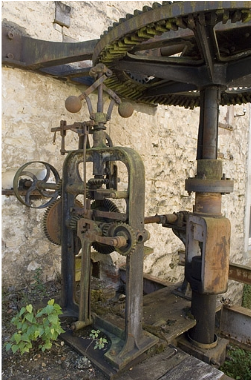
Partie supérieure de la turbine hydraulique. Régulateur à boules.
