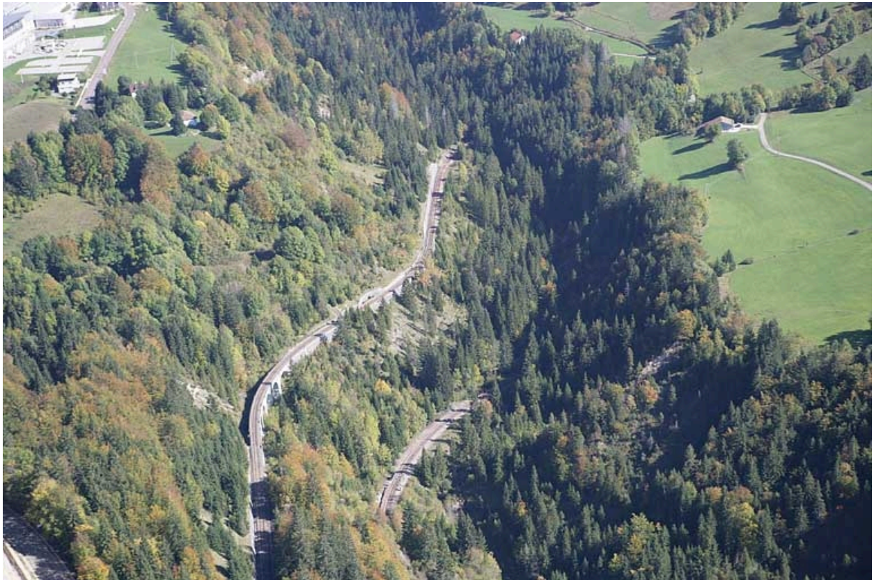
Vue aérienne de la vallée et des accès au tunnel, depuis le sud-ouest.
