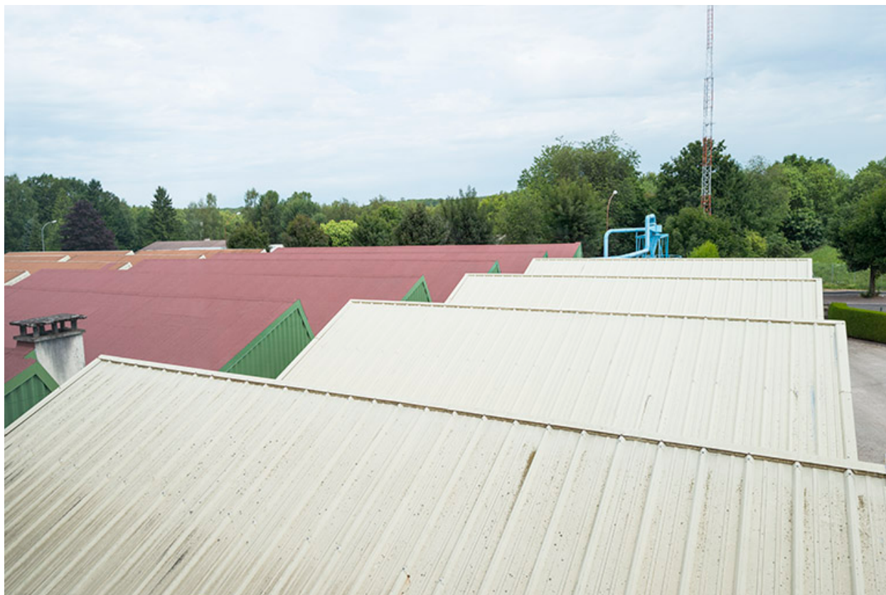
Toitures des ateliers : détail
