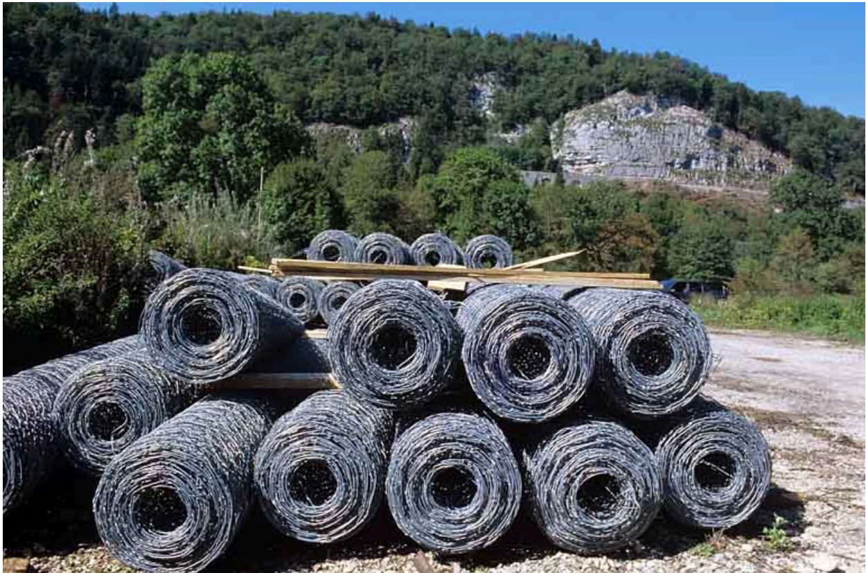
Sécurisation de paroi rocheuse à Syam : rouleaux de filets de protection.
