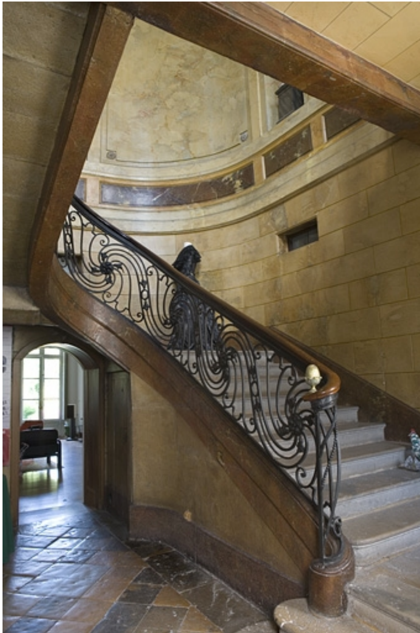
Hôtel en fond de cour, escalier : détail de la première volée avec la rampe en ferronnerie.
