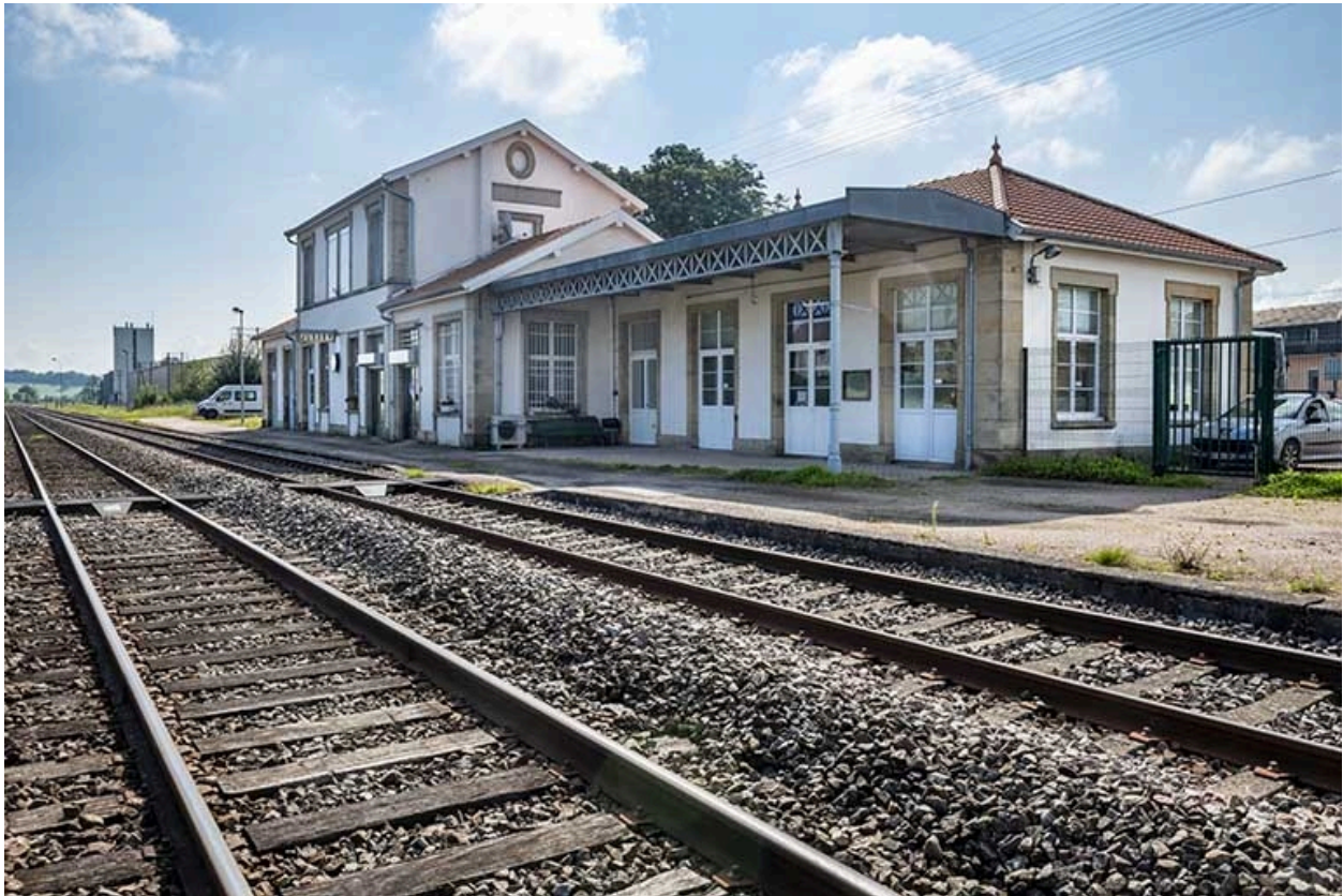
La gare, vue éloignée depuis les voies.
