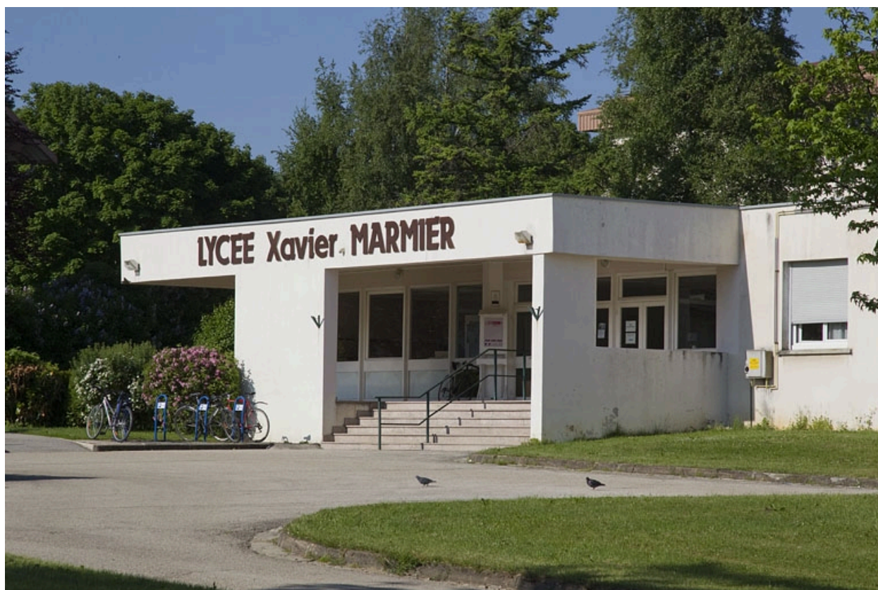
Bâtiment de l'administration : entrée.
