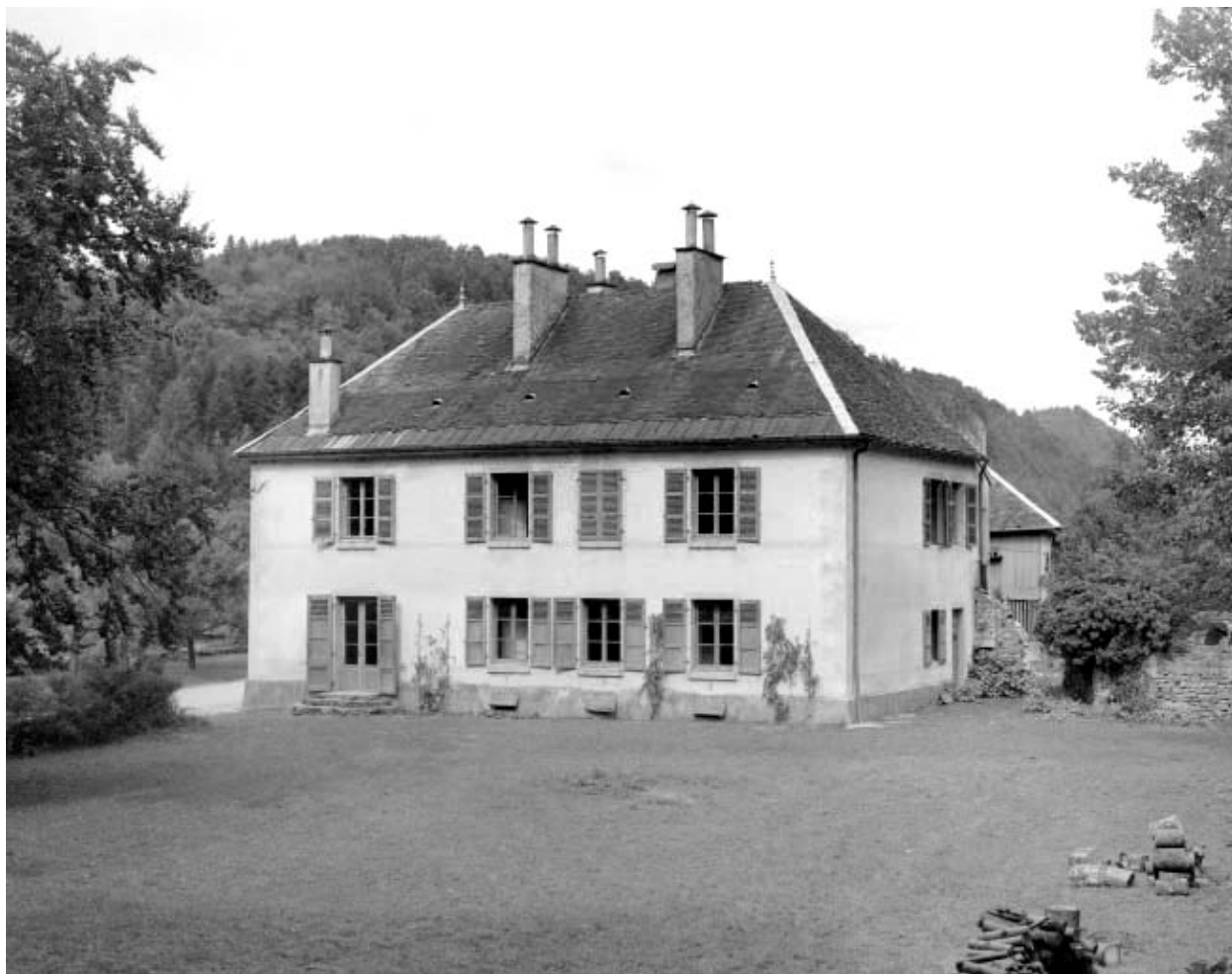
Façade latérale droite de l'habitation, vue rapprochée.
