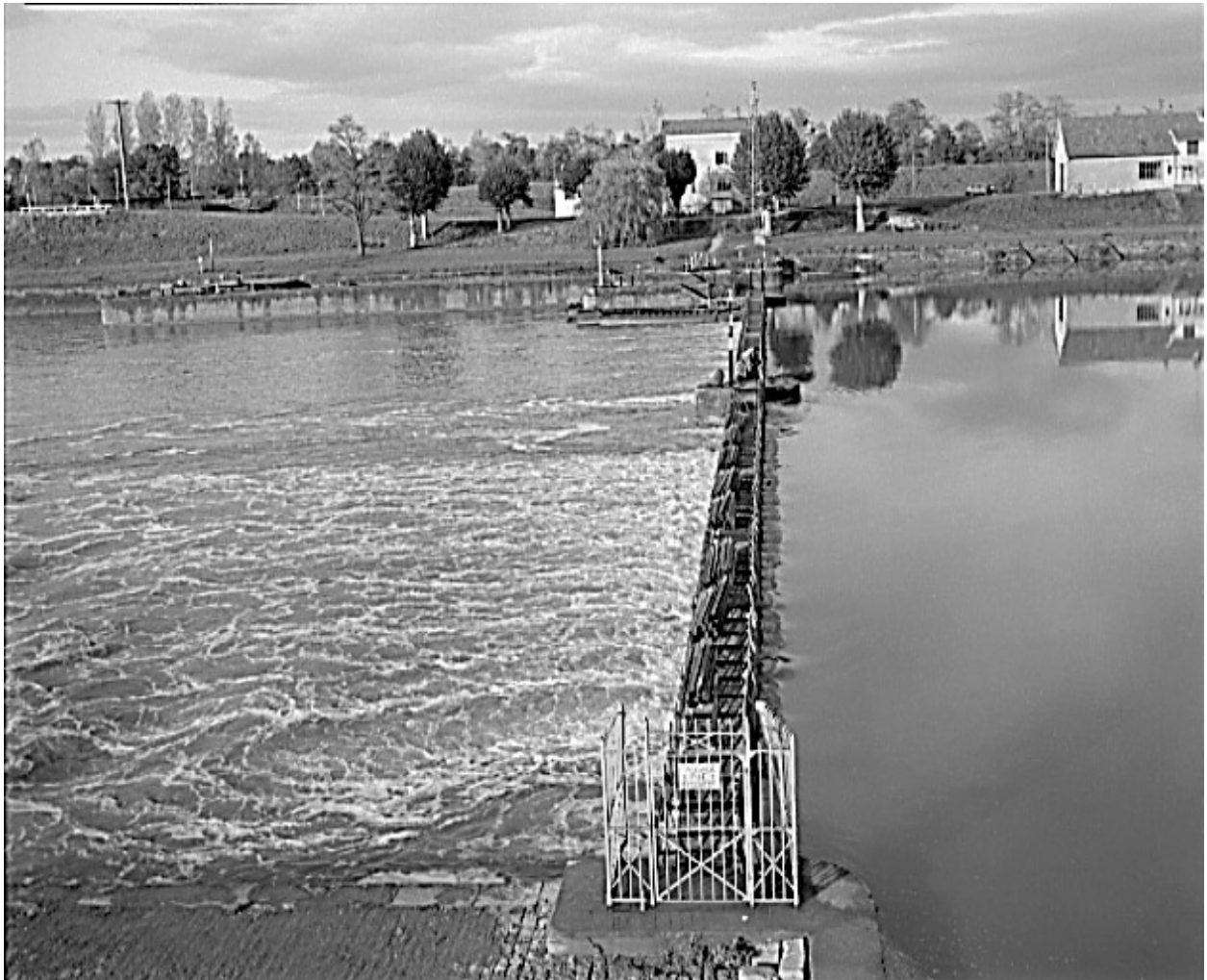
Vue d'ensemble du barrage (en 1986).
