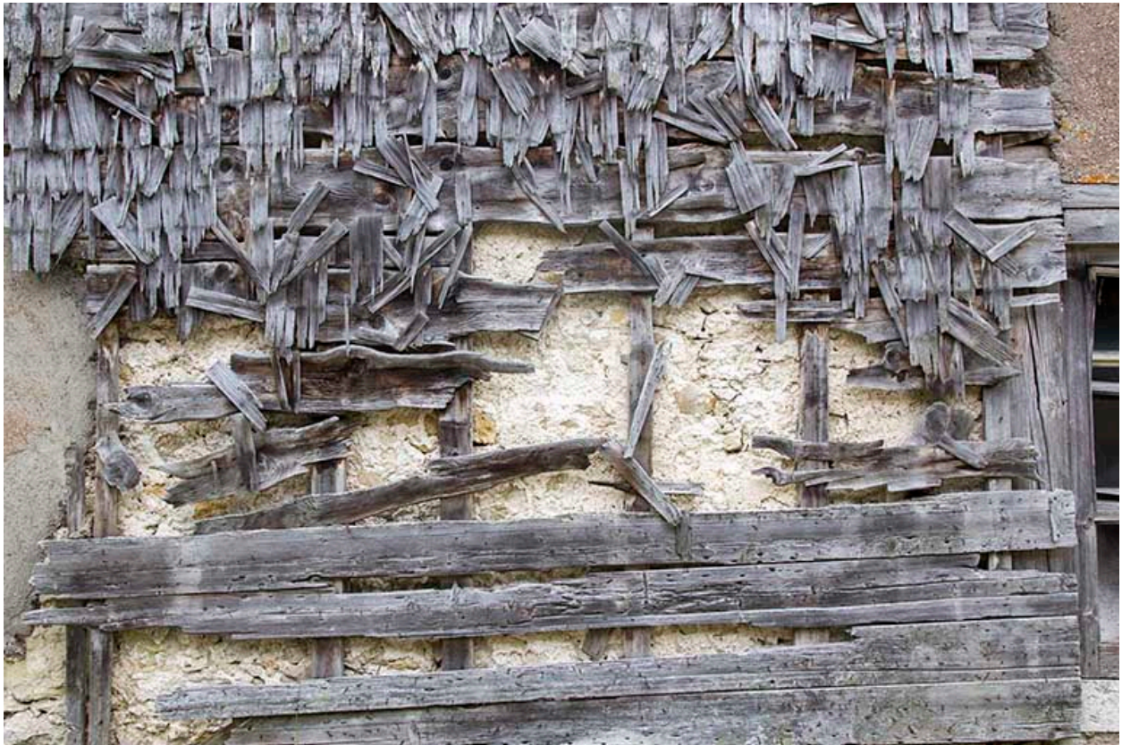
Façade postérieure : vestiges de l'essentage de tavaillons.
