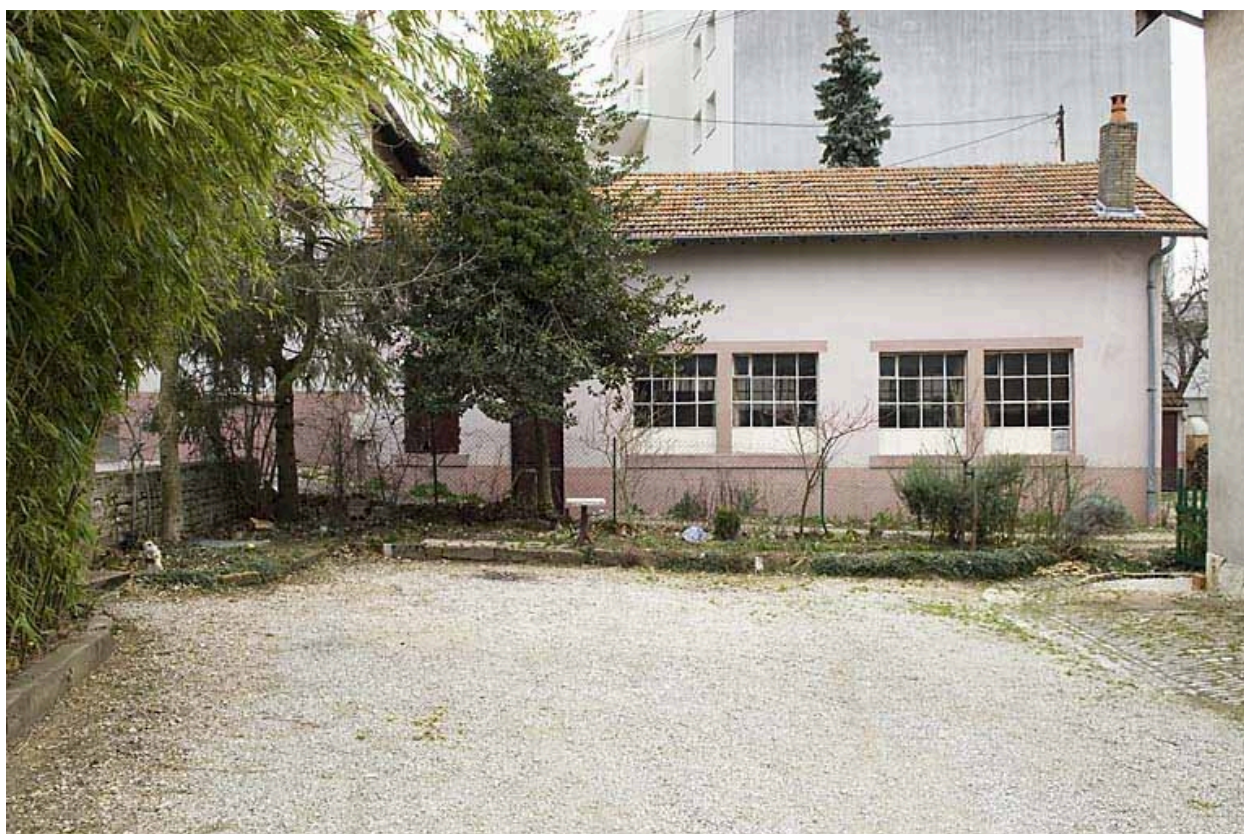
Façade ouest de l'atelier de fabrication.
