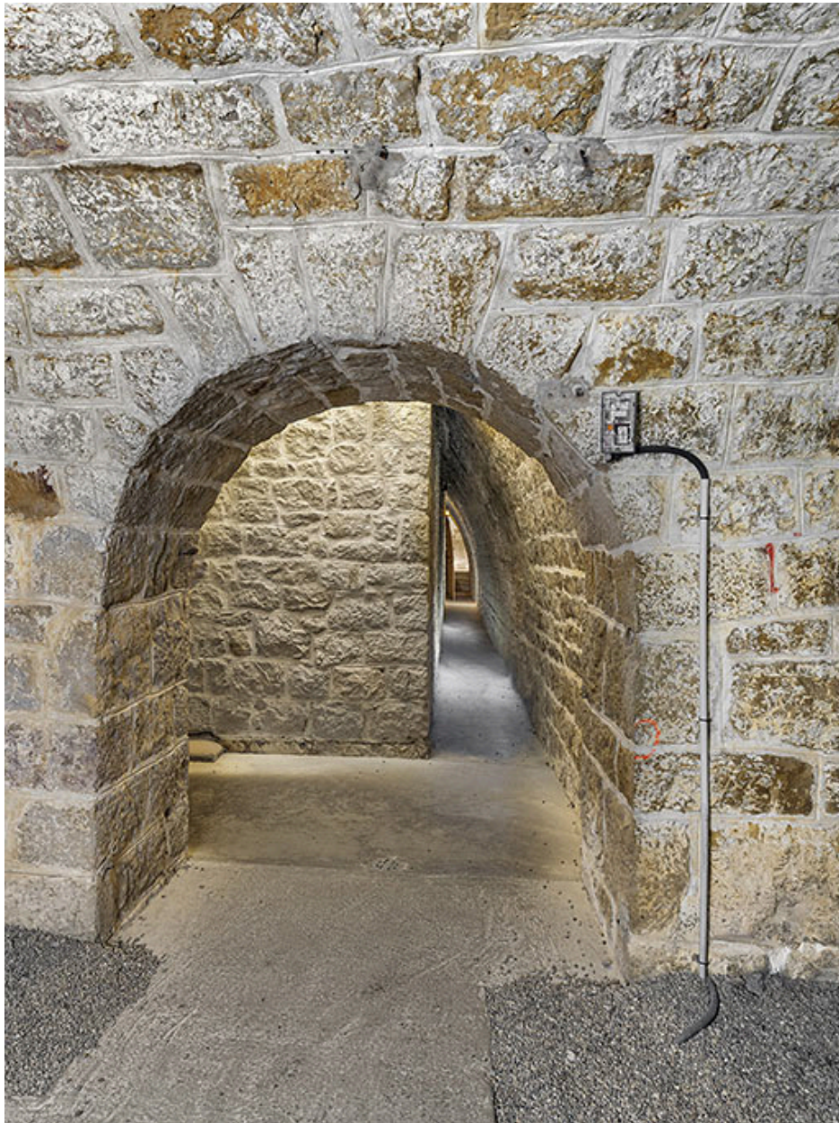
Vue sur la galerie d'assainissement du magasin à poudre.
