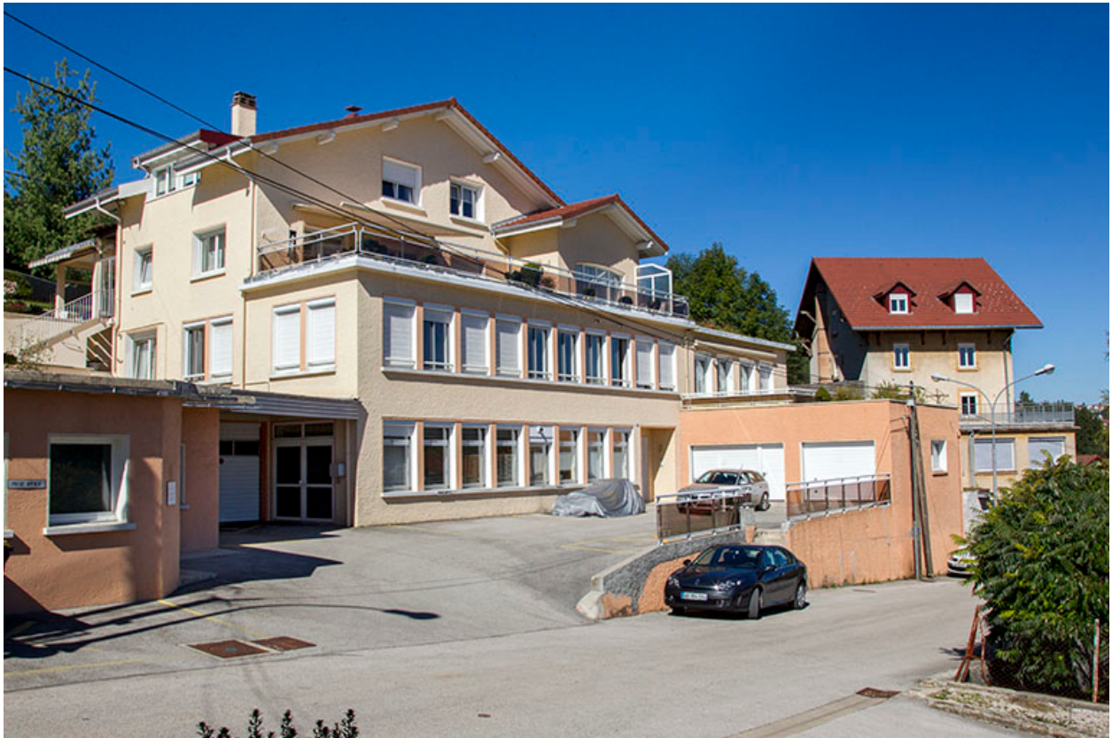
Façades antérieure et latérale gauche.
