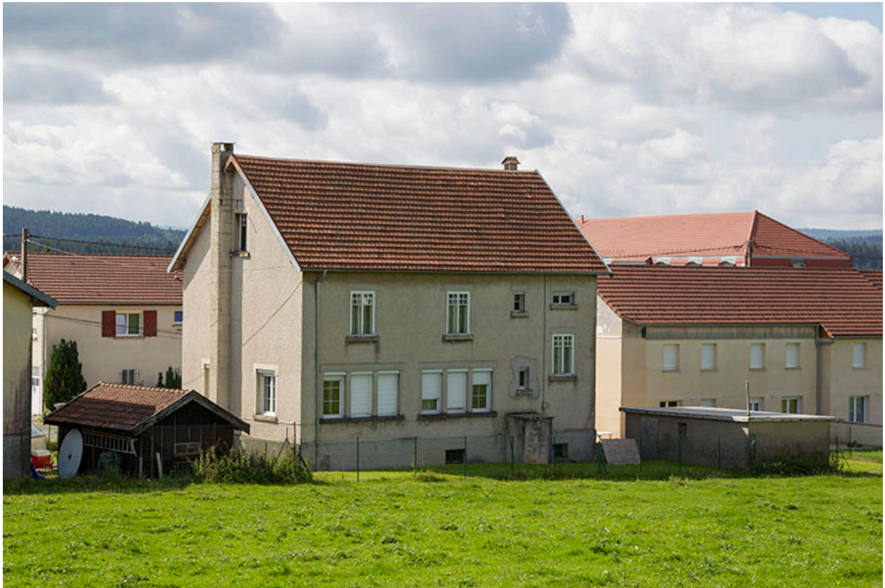
Façades postérieure et latérale droite.
