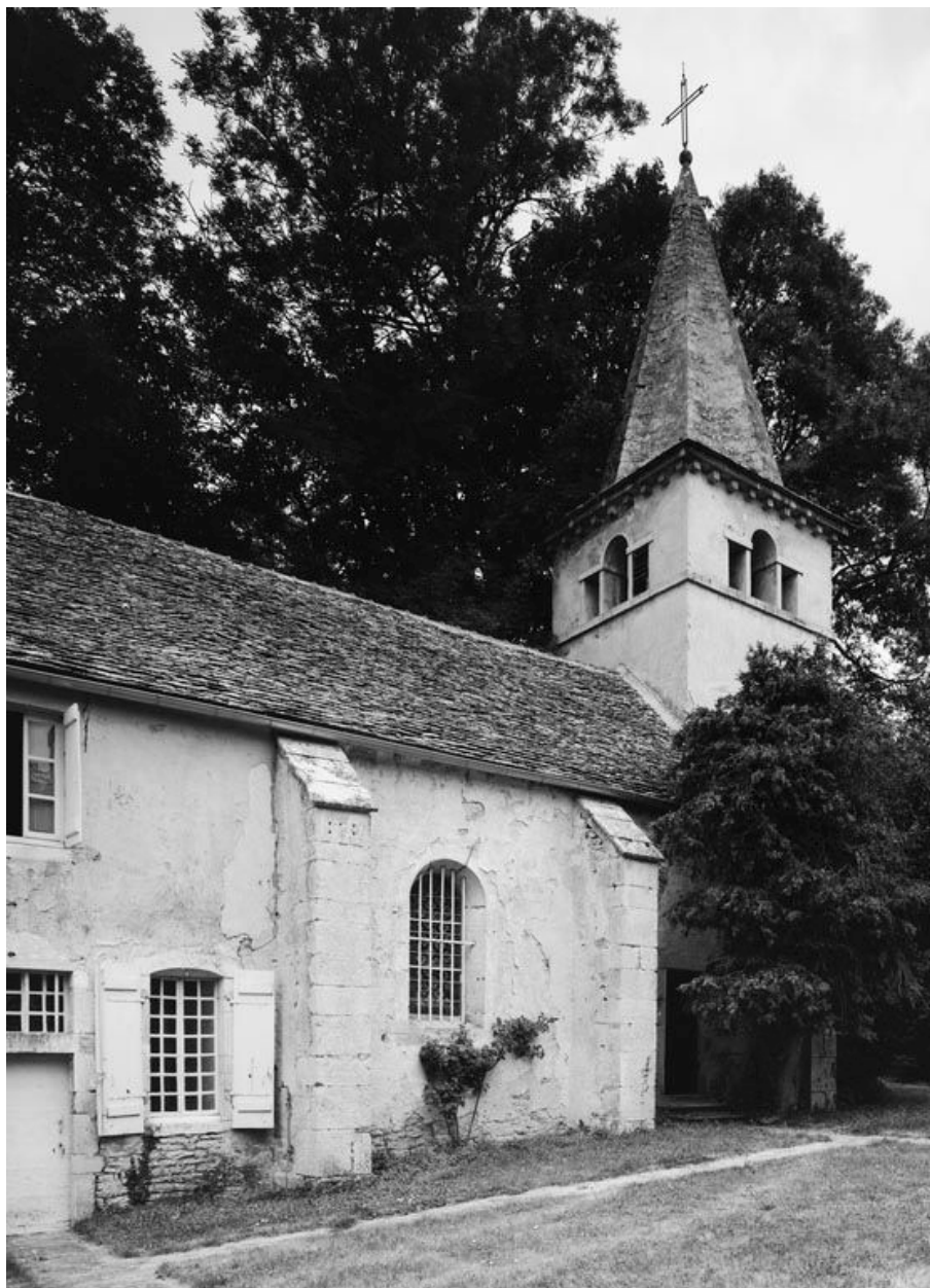
Vue de l'élévation gauche.
