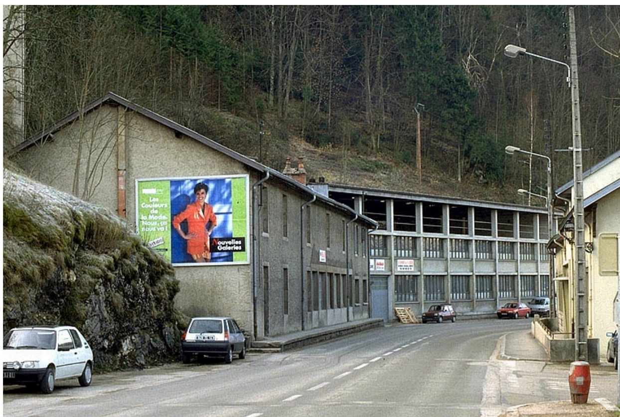
Façades antérieure et latérale gauche.
