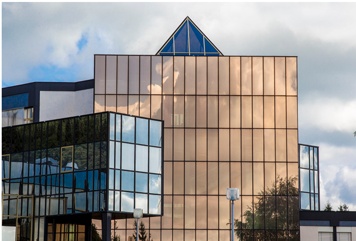
Bâtiment de l'escalier d'honneur, depuis le sud-ouest.
