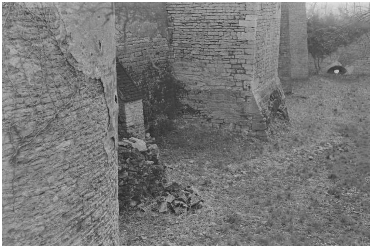
Enceinte : contreforts extérieurs. Détail : le pied des contreforts (photo prise en 1969).
