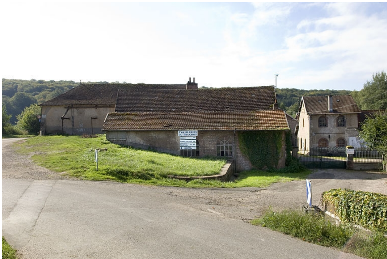
Les bâtiments à l'entrée de l'usine.
