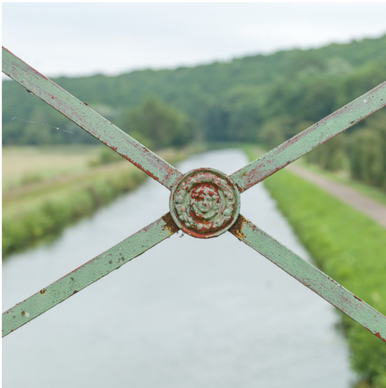
Détail du garde-corps.
