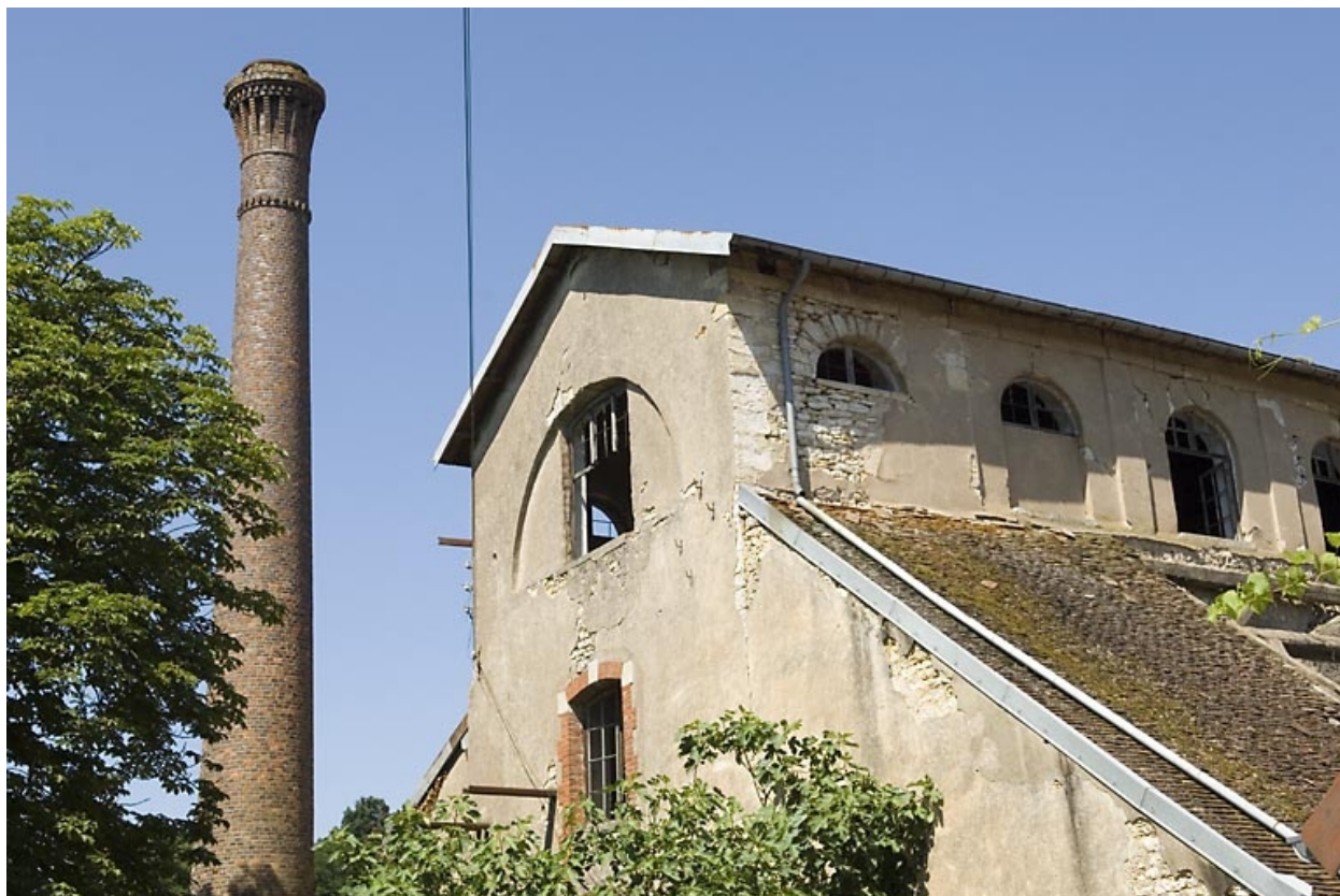
Cheminée et partie supérieure du haut fourneau.
