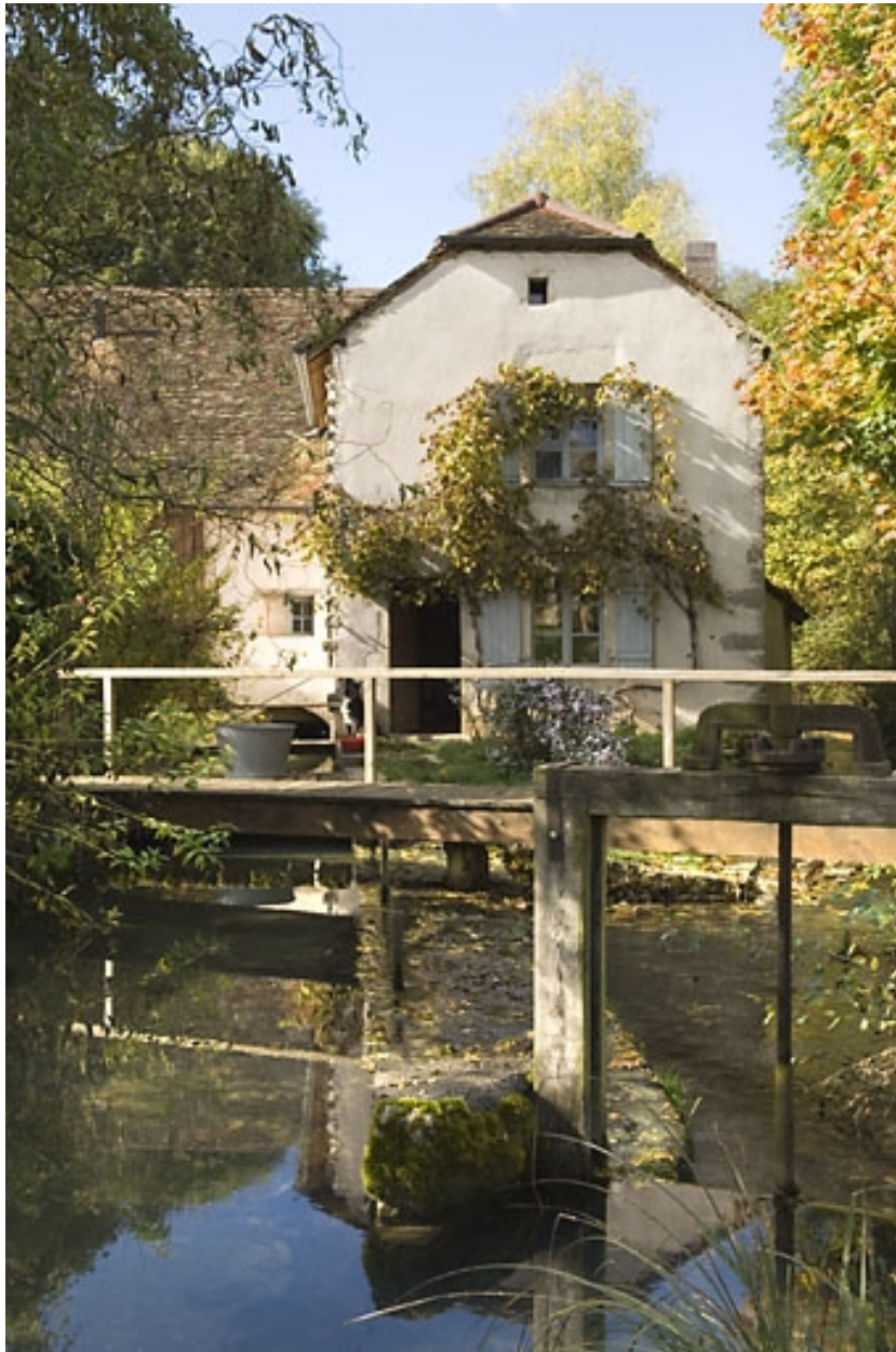
Moulin de Fondremand : vue d'ensemble depuis l'est, avec le bief d'amenée.
