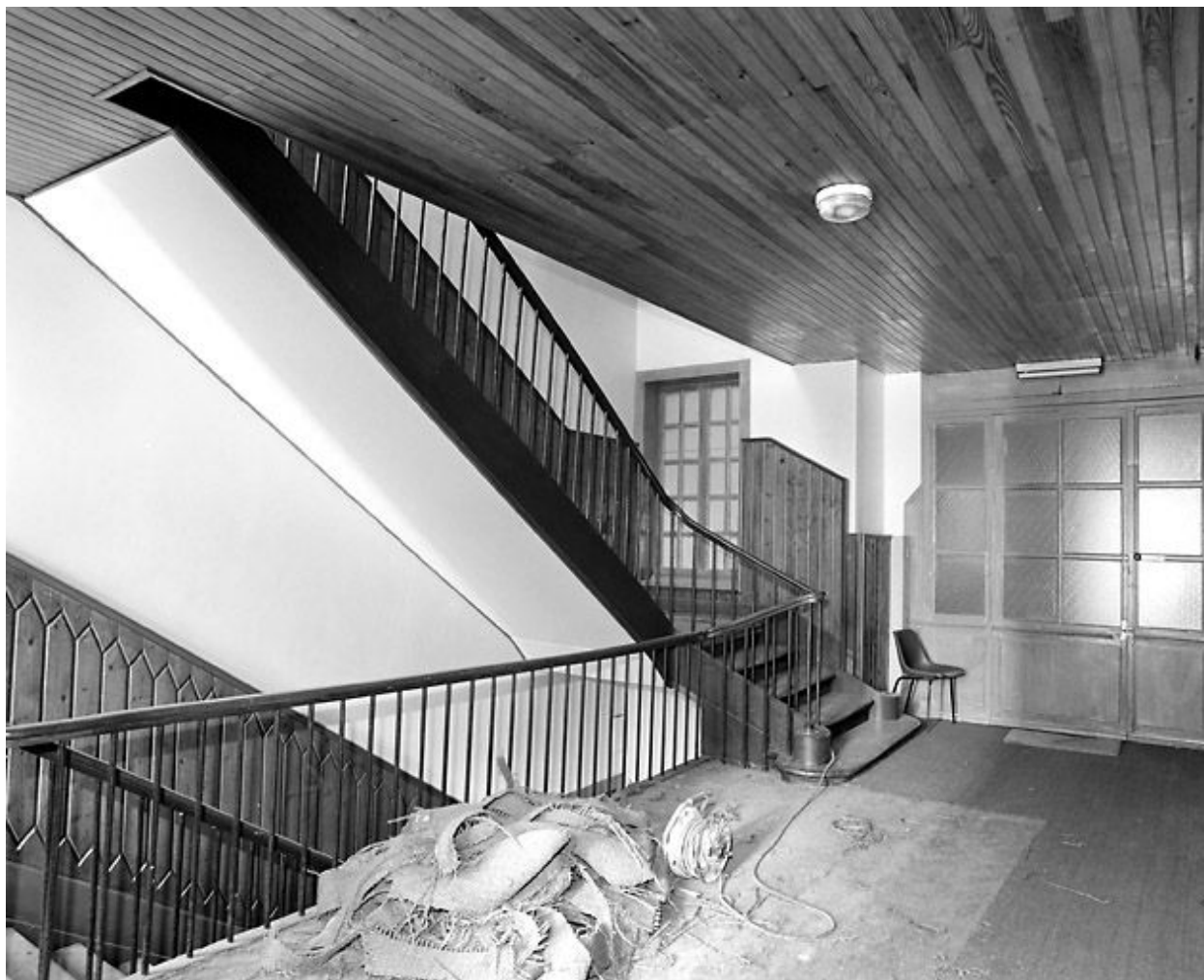
Escalier : un palier.
