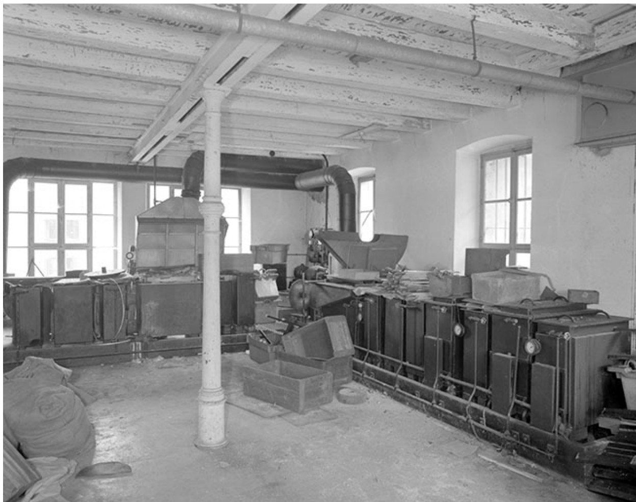
Atelier de fabrication (rez-de-chaussée) : chaîne d'électrolyse.
