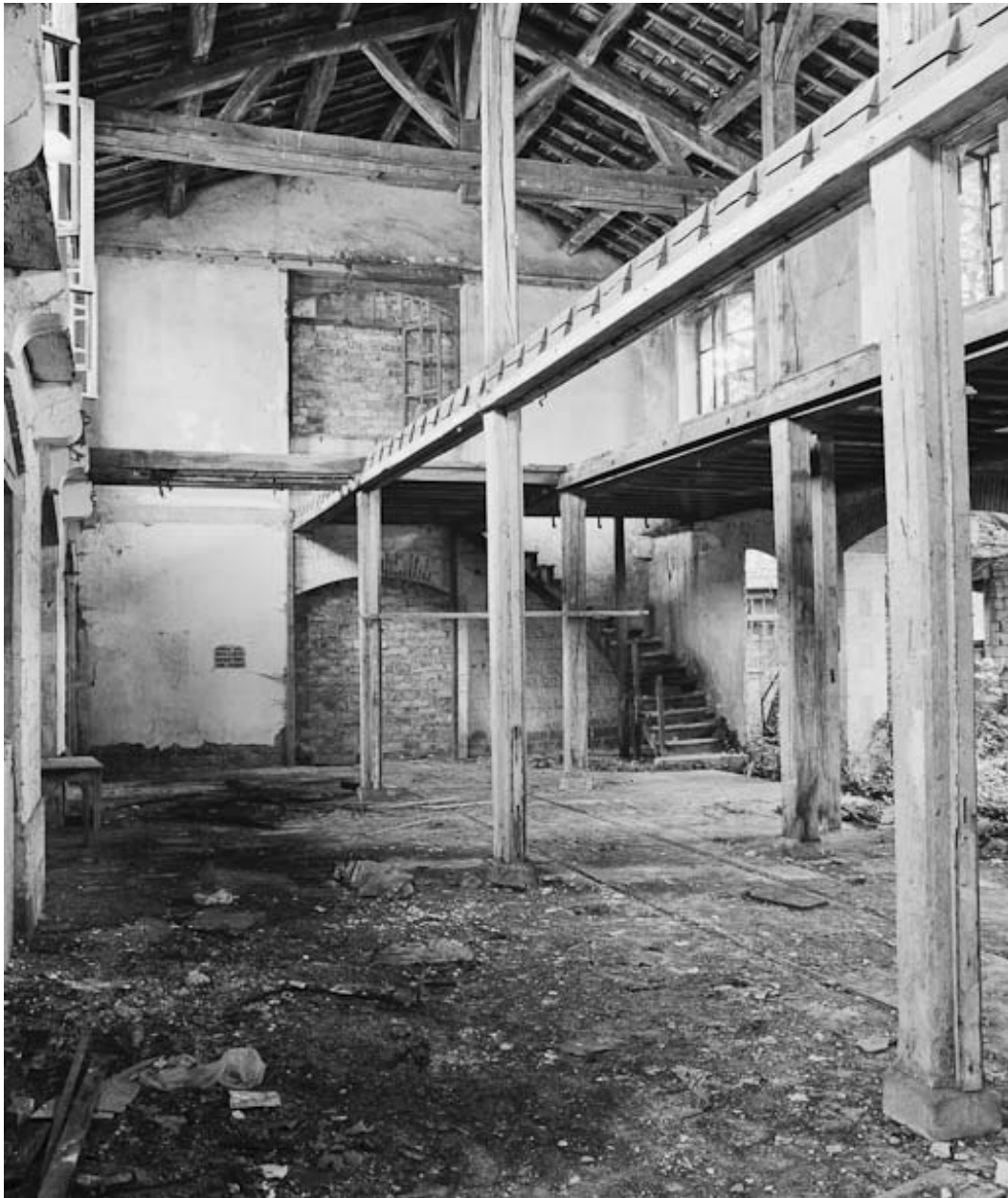
État en 1984, vue intérieure.
