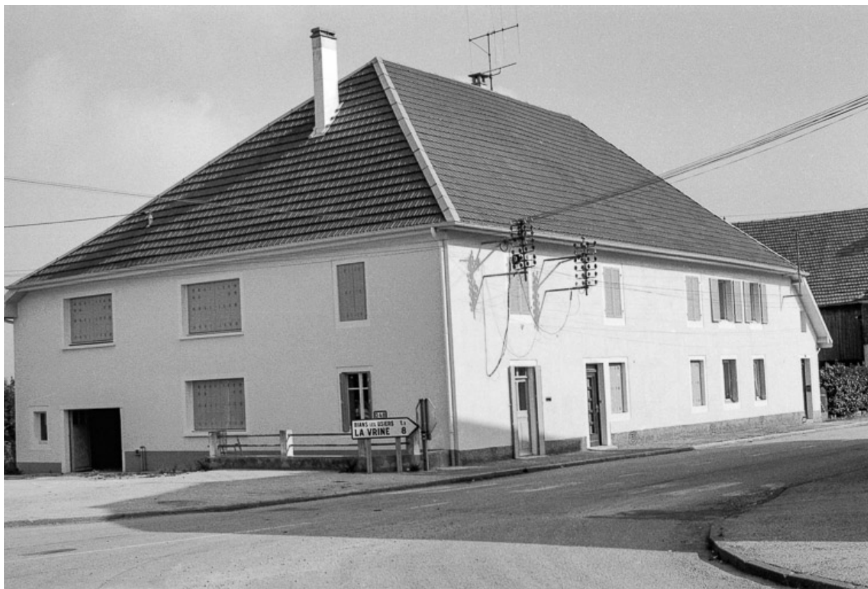
Ferme : façade antérieure et latérale gauche.
