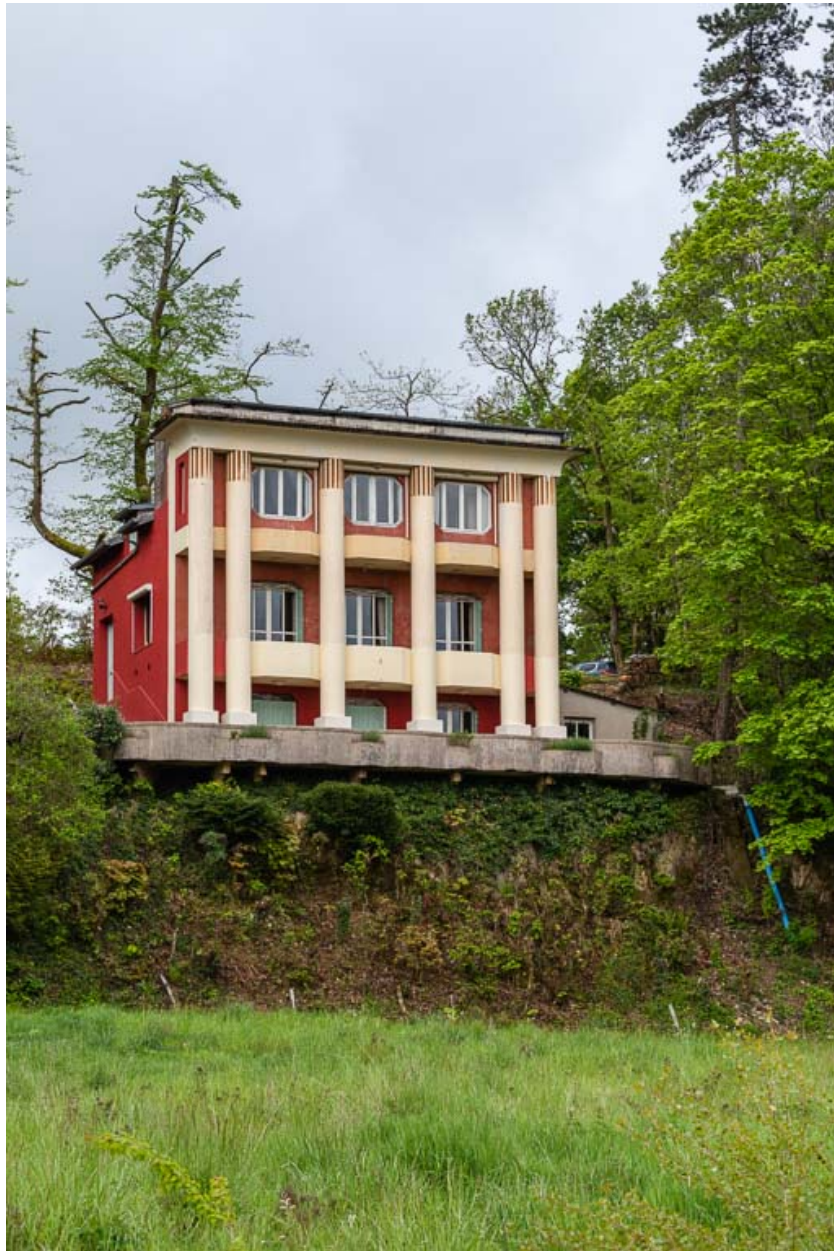
Façade nord, vue de trois quarts.
