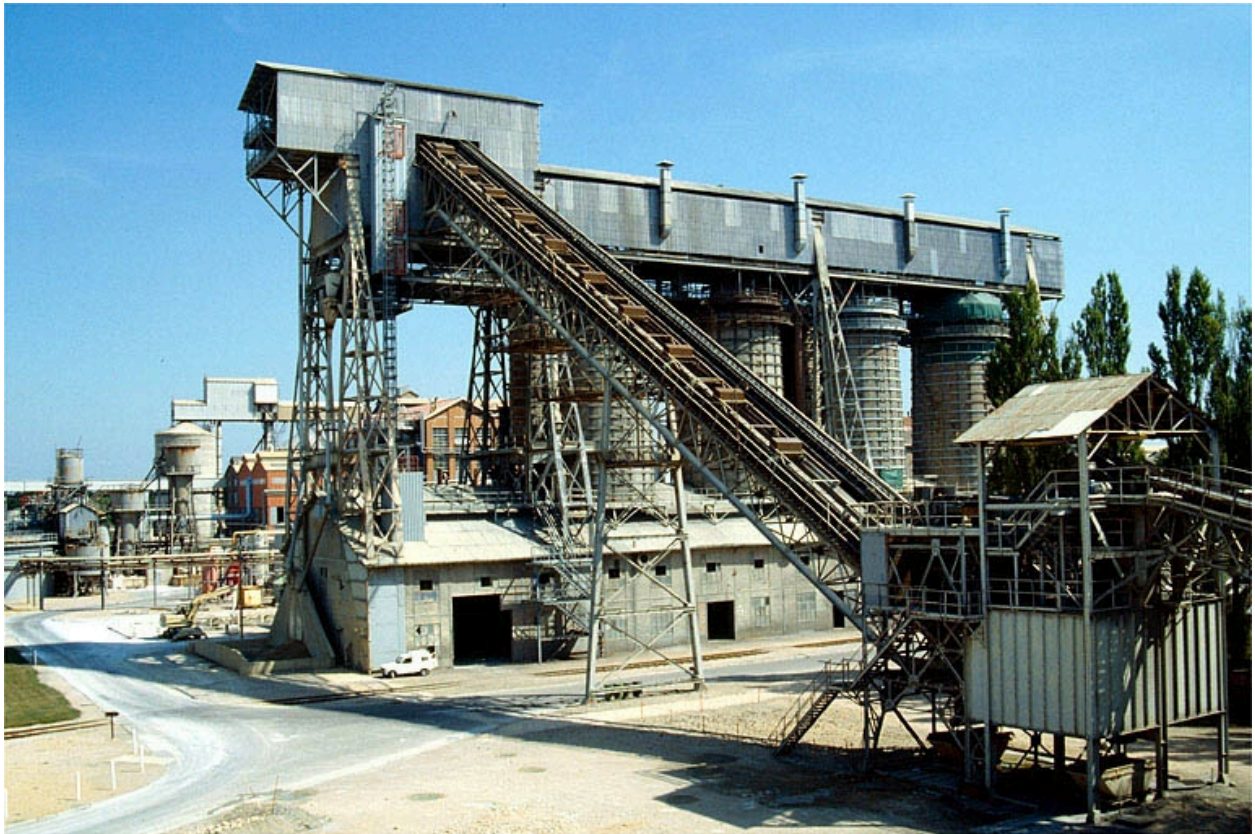
Usine de la société Solvay et Cie, Abergement-la-Ronce : fours à chaux.
