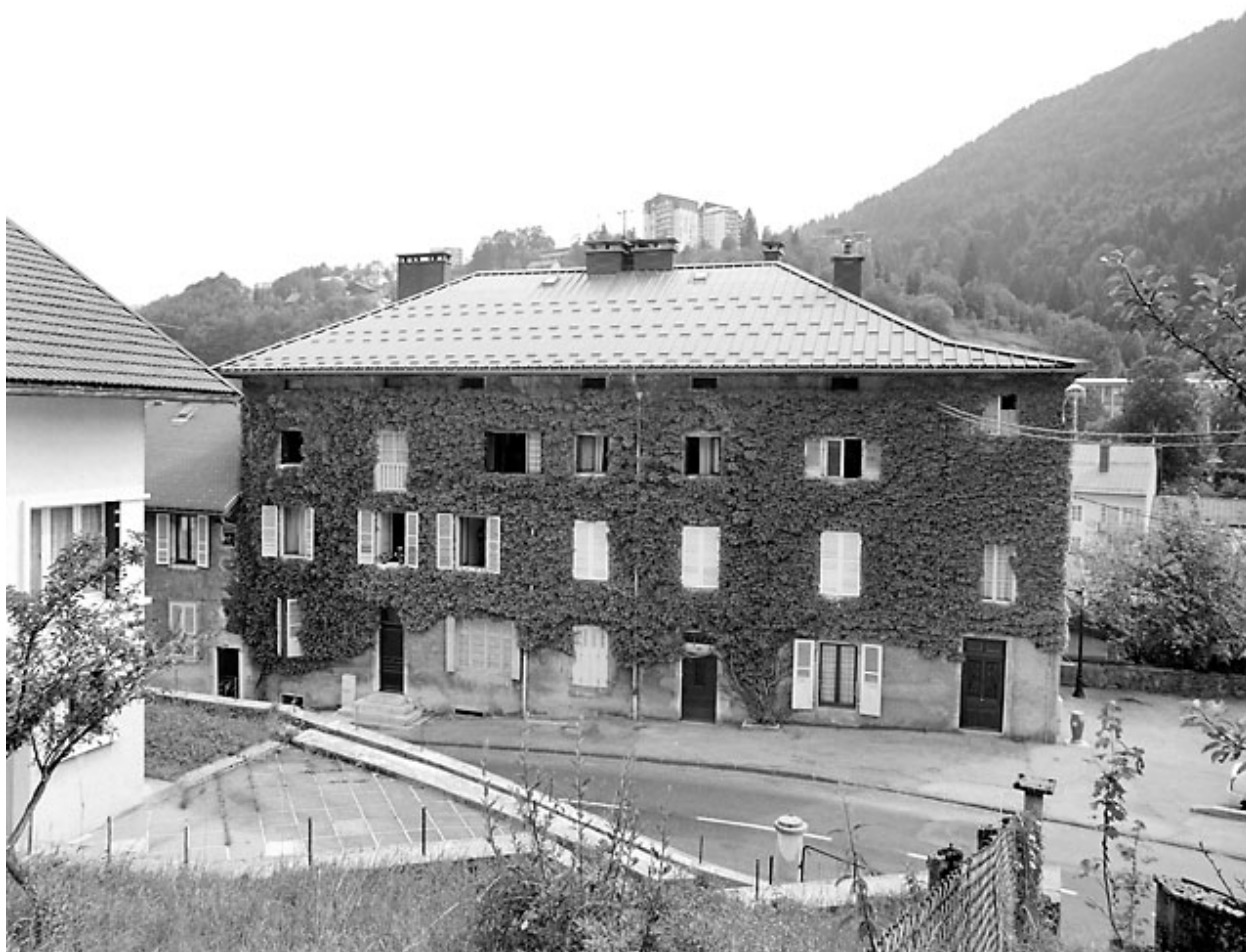
Bâtiment 11-15 rue Pasteur : façade antérieure.
