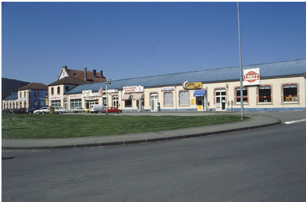
Vue rapprochée depuis le sud-est.
