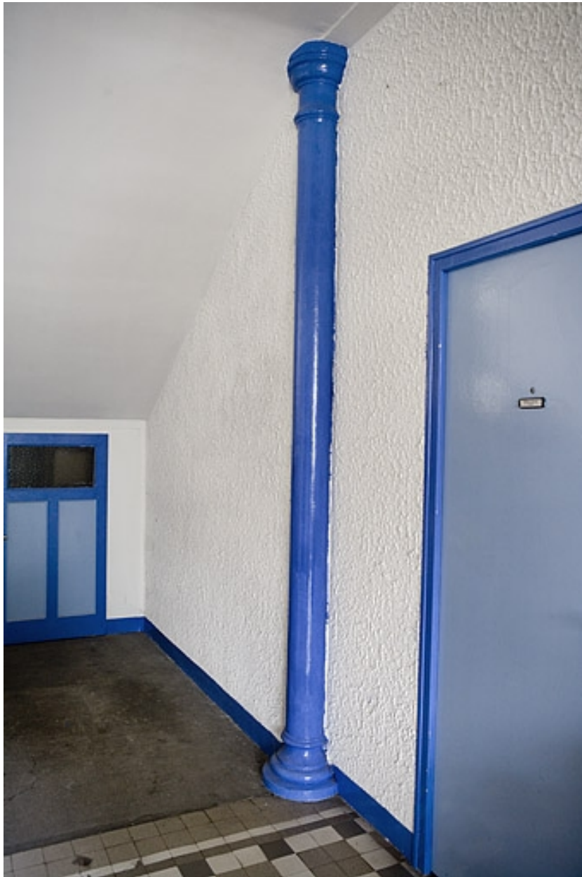
Intérieur de l'entrée : poteau en fonte.
