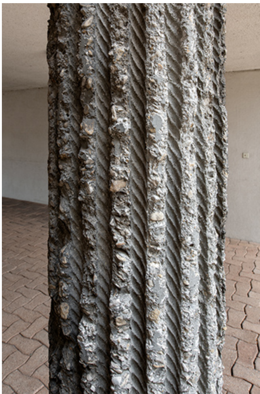
Colonne, détail : empreintes de cordes de chanvre placées en fond du coffrage.
