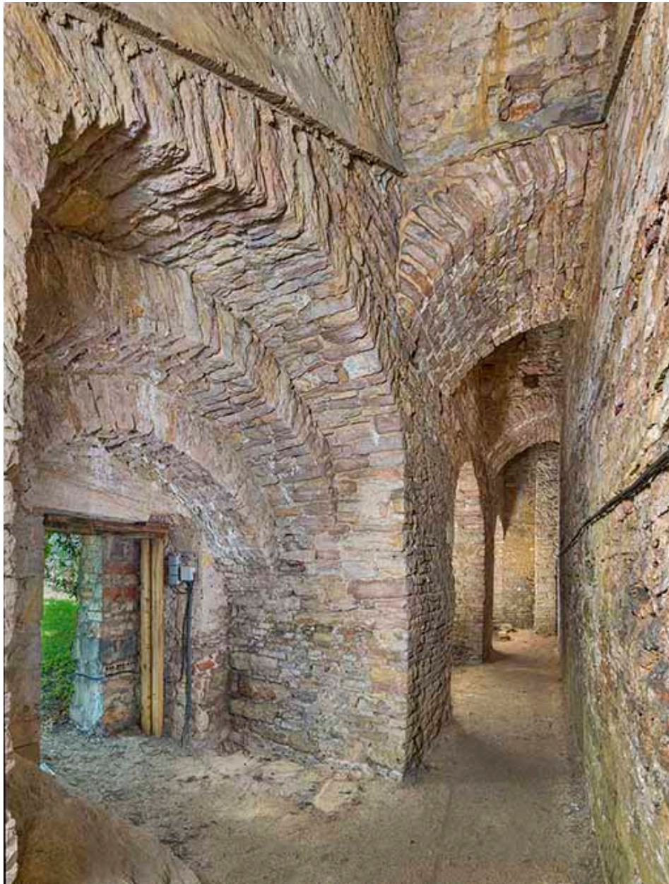
Poterne d'accès à la galerie.
