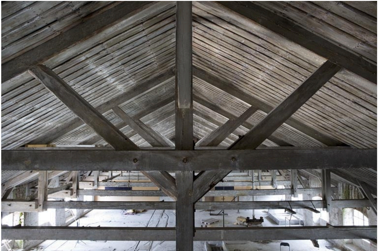
Charpente de l'atelier de préparation de la pâte. Vue de face.
