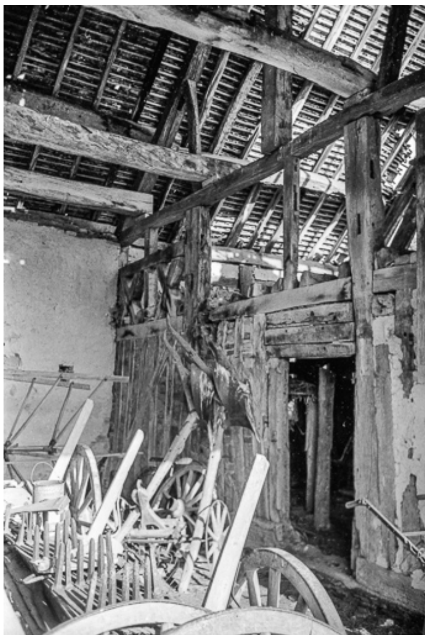
Ferme cadastrée 1956 A1 142-143 : détail de la charpente.
