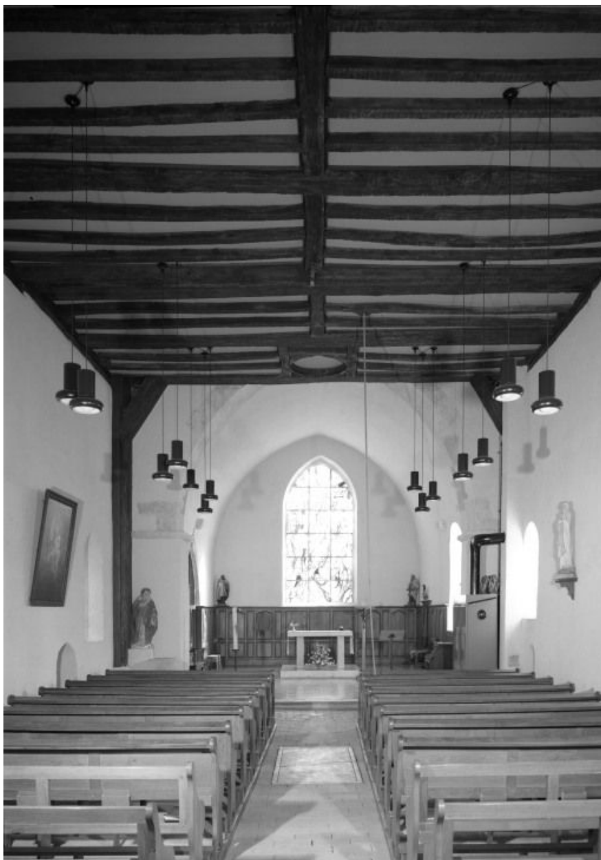
Vue intérieure prise de l'entrée
