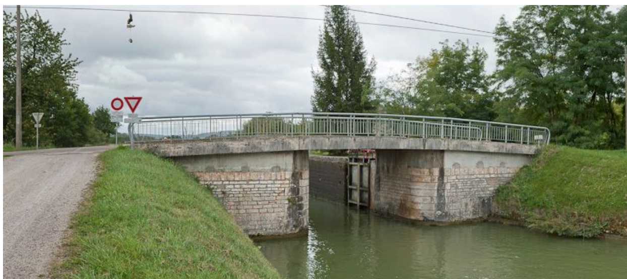
Vue du pont depuis l'aval.
