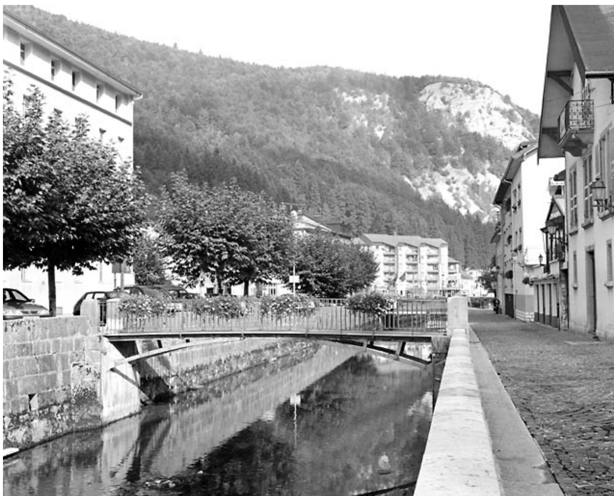
Passerelle amont, vue de l'amont.
