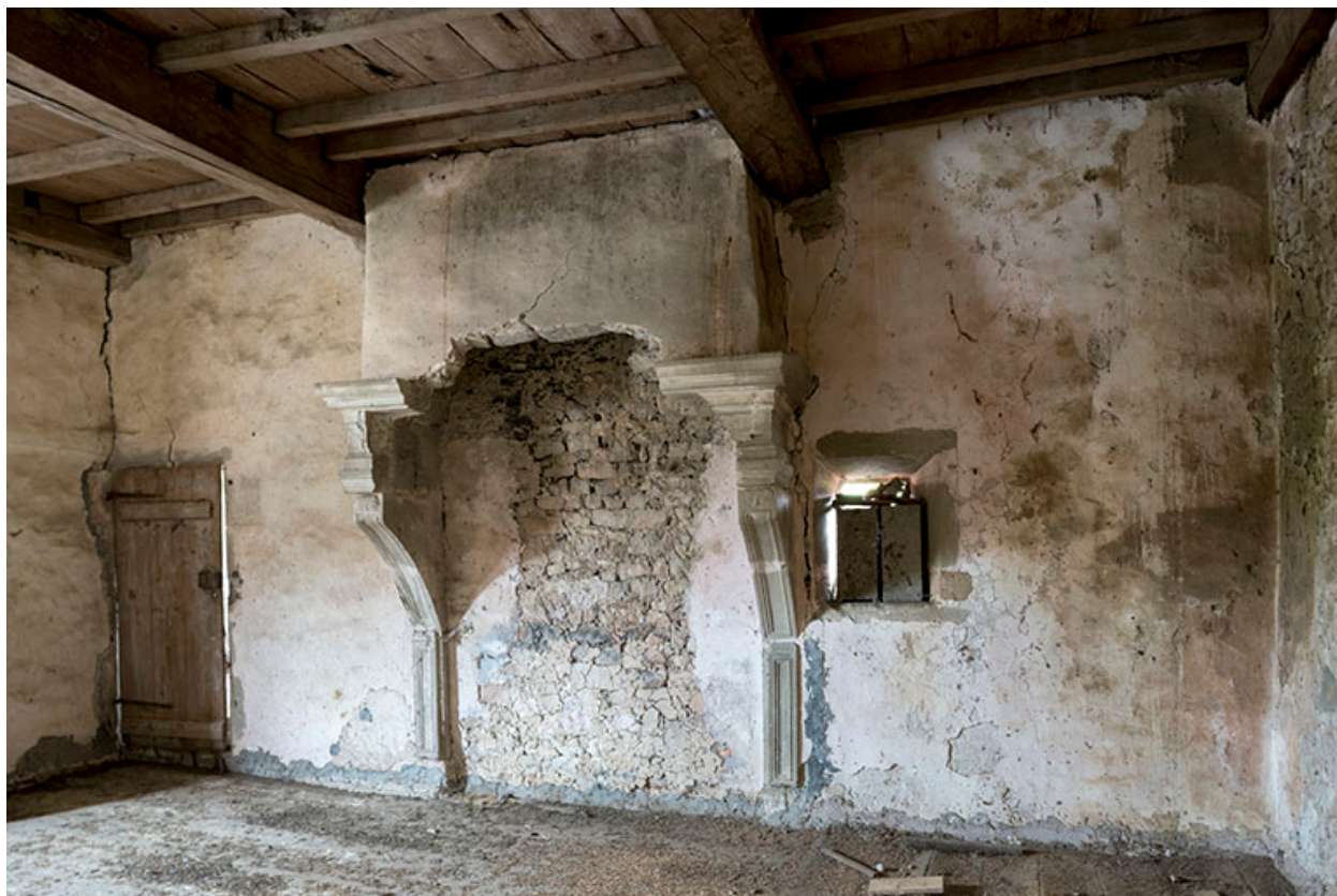
Cheminée adossée, à l'étage de l'ancien logis.
