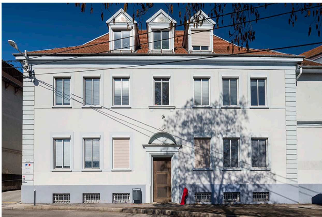
Façade antérieure des bureaux.
