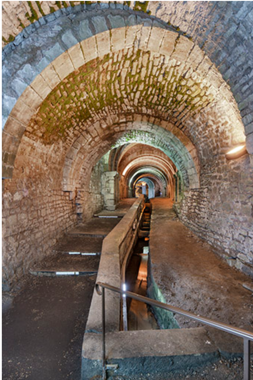
Galerie de communication depuis le puits d'Aval (ou à Grès).
